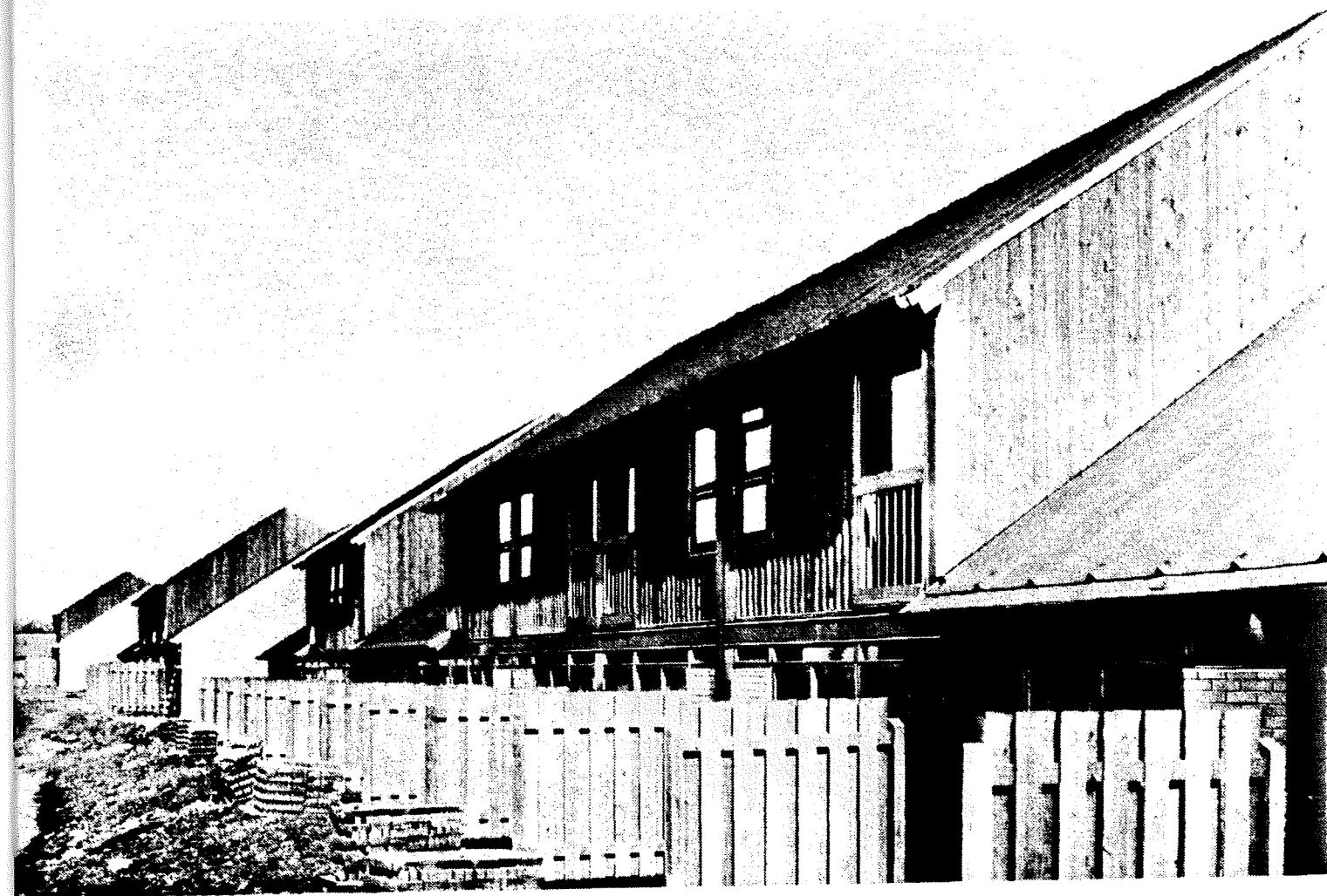
Figur 5. Billedet viser springene i tagfladerne, som giver anledning til gavlparterier.
